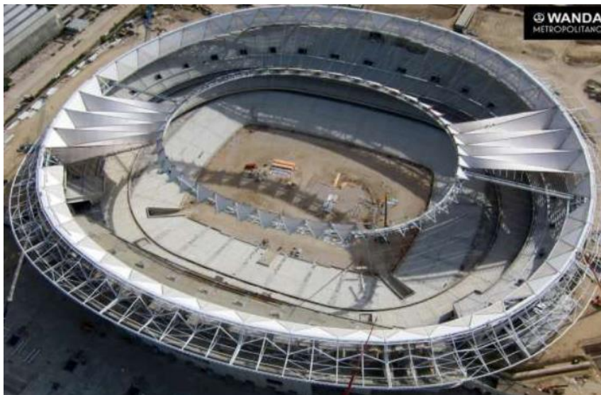
Figura 17. Construcción Wanda metropolitano. Tomado de (Marzo, n.d.)
